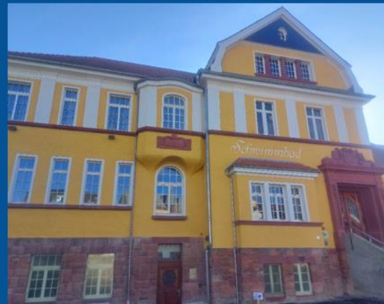
Theater Altes Hallenbad
